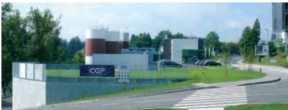
Nova čistilna naprava v vgrajeno sodobno membransko tehnologijo, ki jo druge uporabljajo pri obdelavi pitne vode za vodoskrbo
