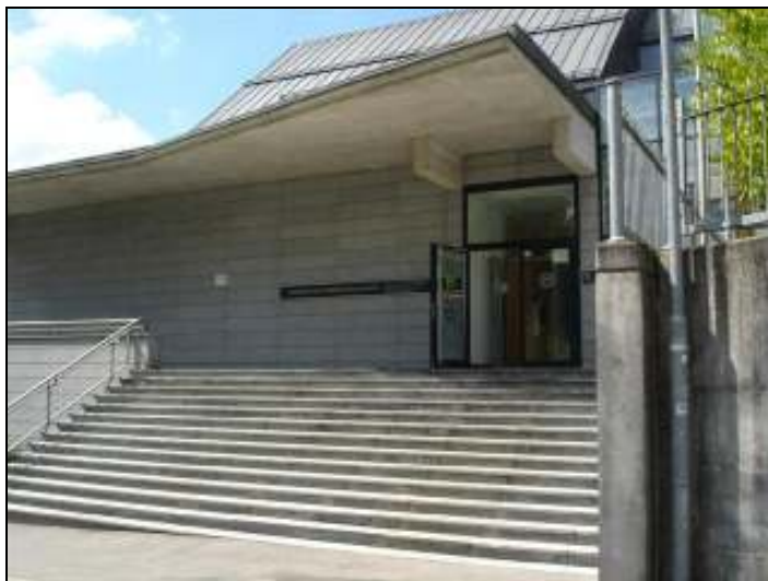
- vhod v stavbo Visokošolskega središča Novo mesto -
