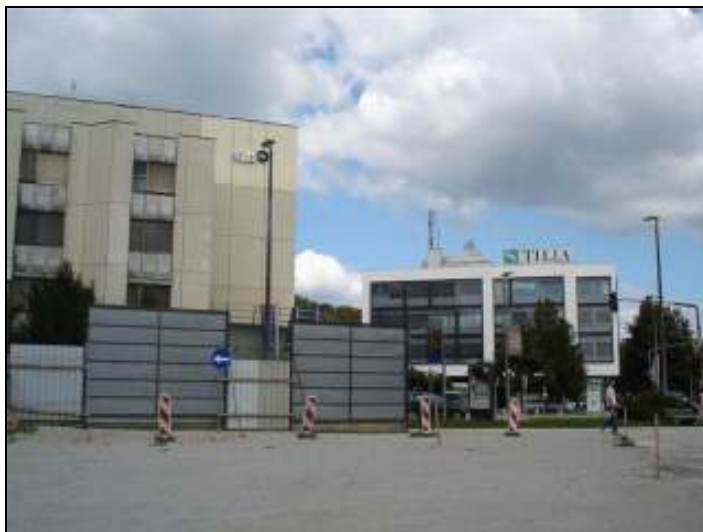
- makadamsko parkirišče na mestu porušene stavbe Novi trg 6 -
