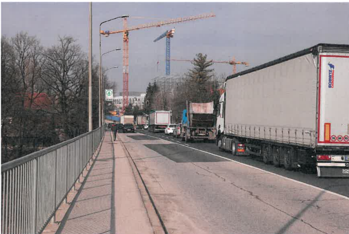
Slika 7: Iz smeri Žabje vasi se na mostu pogosto zadržujejo stoječe kolone vozil in ko z nasprotni smeri pripeljejo tovornjaki s hitrostjo 70 km/h (!?), vozniki v stoječih vozilih začitijo občutno valovanje mostu (foto: Boštjan Pucelj).
