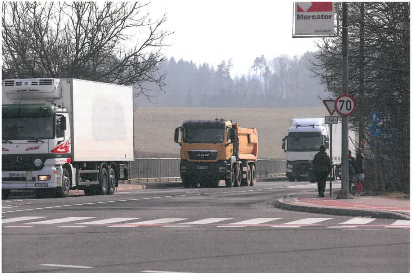
Slika 1 in 3: Neustrezni prometni znak na vstopu na Ločenski most iz križišča v Ločni, ki dovoljuje vožnjo po mostu do 70 km/h, slabo viden pa je tudi moder prometni znak, ki prepoveduje vožnjo kolesarjem po površinah, ki so namenjene pešcu (foto: Boštjan Pucelj).
